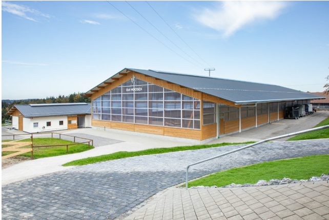
Bild 3d_ Geschäftsbereich Landwirtschaftsbau/Reitanlagen
