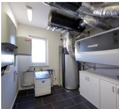
^ Praktisches Technikmodul: Mit unserer vorgefertigten Technischeinheit lässt sich die Haustechnik auch auslagern – entweder an Carport oder Garage angebaut oder allein stehend – das schafft mehr Platz im Haus.
