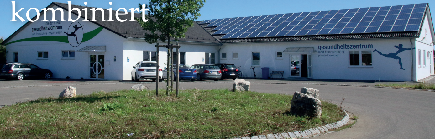
Seine neuen Praxen baute Michael Niedermeier mit Haas Fertigbau.
