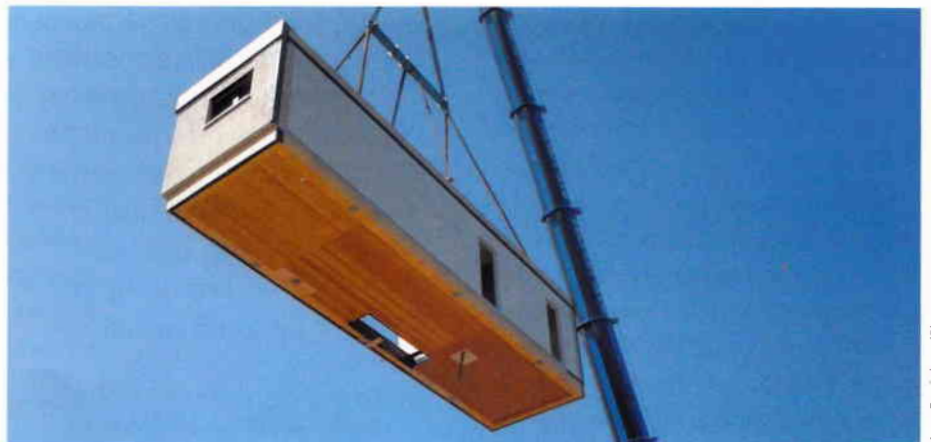
Fertigmodule eignen sich besonders für Standardräume und enthalten bereits die komplette technische Gebäudeausrüstung.
