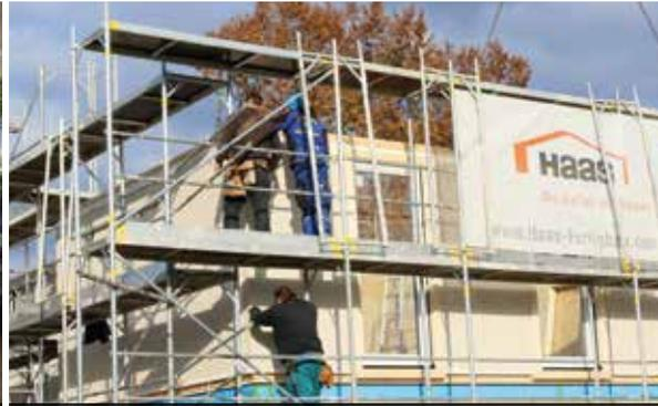
Die Außenhülle eines Holz-Fertigbaus steht in wenigen Tagen.
