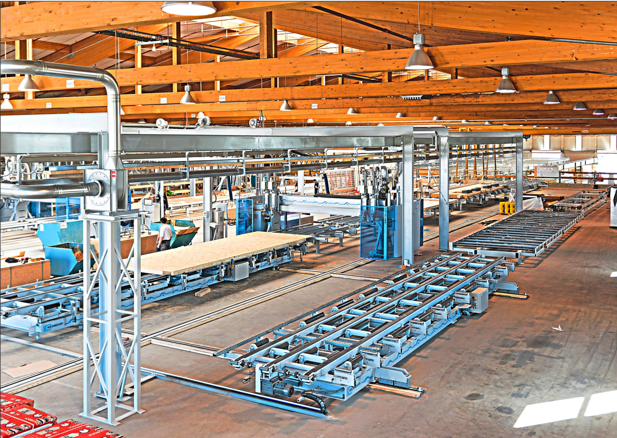
Hausbau in der Halle: Viele Schritte können in den Werkshallen des Unternehmens abgewickelt werden, hier werden Wandelemente gefertigt. – Fotos: Haas Fertigbau
