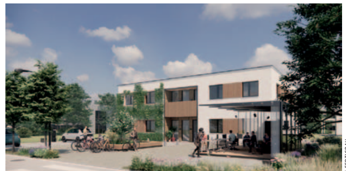
▲ Innovativer Haas Gewerbebau: das Bild zeigt „Haas IO“, einen modernen Gebäudekomplex nach New Work Prinzipien
