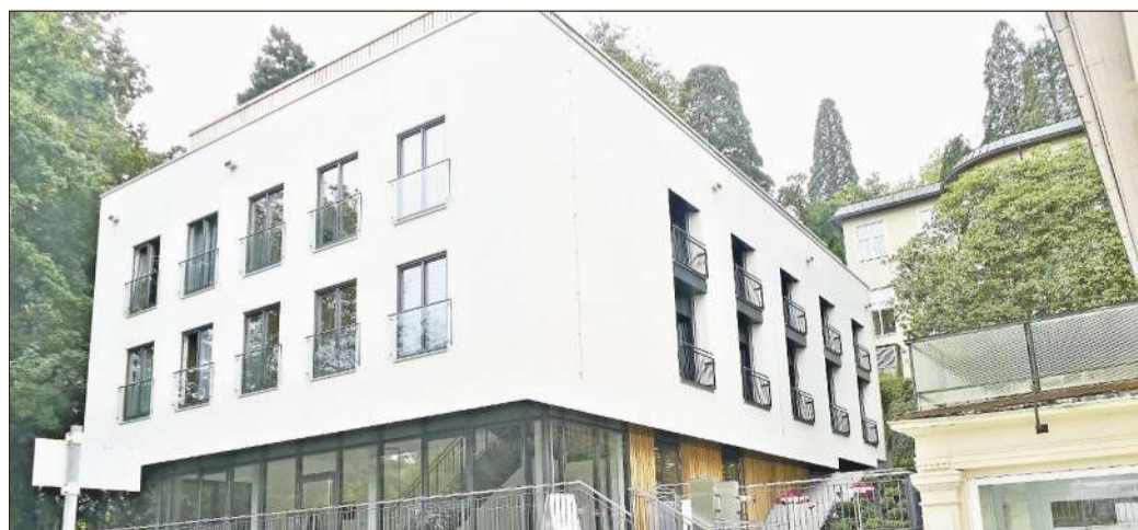
Vier Stockwerke, vier Millionen Euro: In der Dengler-Klinik ist eines der ersten Klinik-Holzhaus Deutschlands entstanden. Foto: Fauth-Schlag
