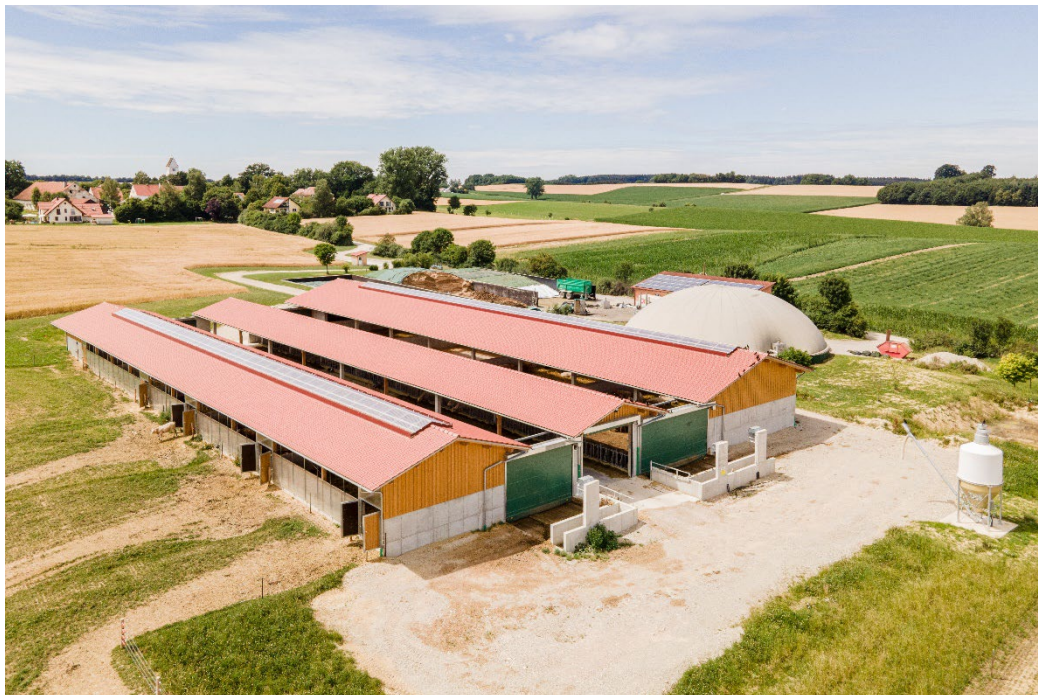
Haas_Leonbacher_2022 © Haas Fertigbau
