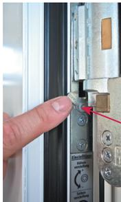
2. Aushebesicherung lösen
